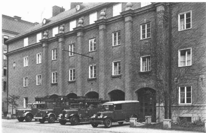
Östermalms brandstation i kv Ripan. Fasaden mot Östermalmsgatan. Foto L af Petersens 1945.
